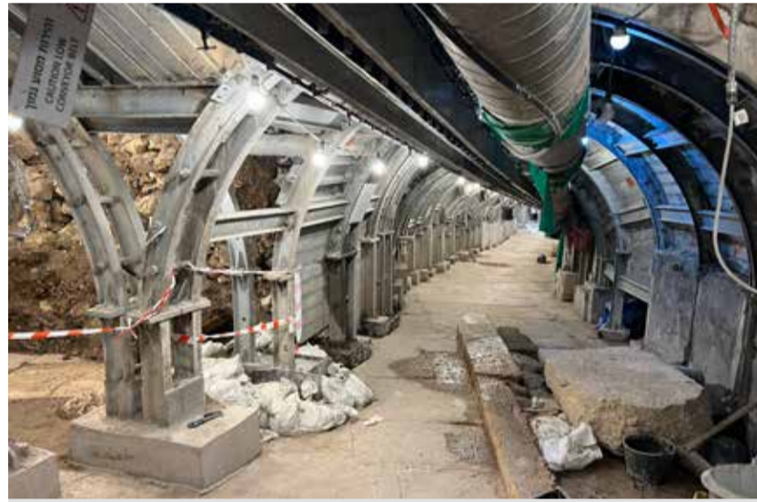
Bei den unterirdischen Ausgrabungen müssen die Archäologen sehr sensibel vorgehen und können sich nur in ganz kleinen Schritten vorarbeiten. Der Tunnel wird durch ein Stahlkonstrukt gestützt, um das darüberliegende Wohnviertel nicht zu gefährden. Finanziert werden die Ausgrabungen von der israelischen Regierung und privaten Spendern. Alle Fotos: Christen an der Seite Israels
